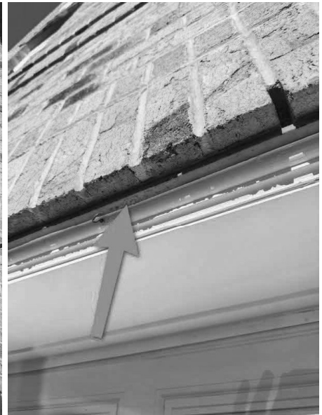
Garage door lintel
