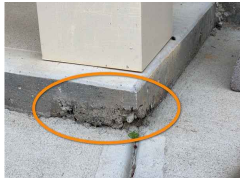
Front entry patio edge
